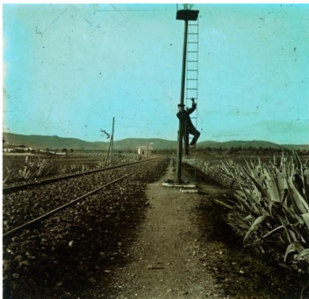
Ilustración 1. Vista general del trazado de la vía en las proximidades de Cabra de Santo Cristo. Operario de mantenimiento en la señal de avanzada de dicha estación.
