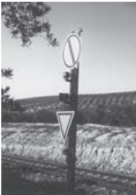
Foto 12.- Disco Sur de España modificado y adaptado el Código Unificado para indicar anuncio de parada/anuncio de precaución (señal compuesta de dos pantallas). Observar que, no obstante se ha dotado de sobre-pantallas o plafones reflectantes, aún se encontraba instalado el alumbrado mediante linternas alimentadas por baterías. Avanzada de Jódar. Foto José Antonio Gómez Martínez.
