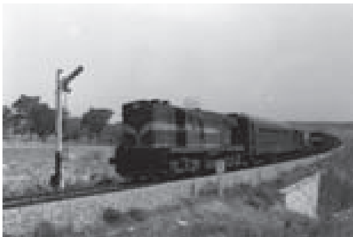
Foto 13.- Semáforo absoluto de entrada en indicación de anuncio de parada –precaución- de la estación de Jódar. Foto José Vicente Coves Navarro.
