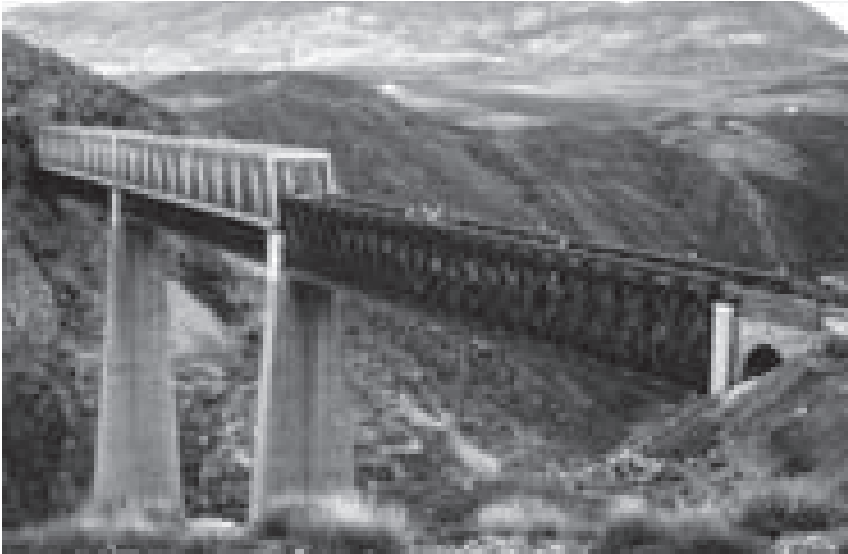
Foto 9.- Trabajos de sustitución de los tableros metálicos originales por otros nuevos de mayor resistencia realizados a base de soldadura. Foto Miguel Cano López Luzatti.
