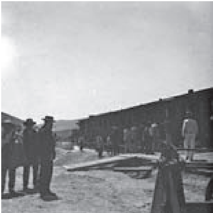
Apeadero del puente del Salado
