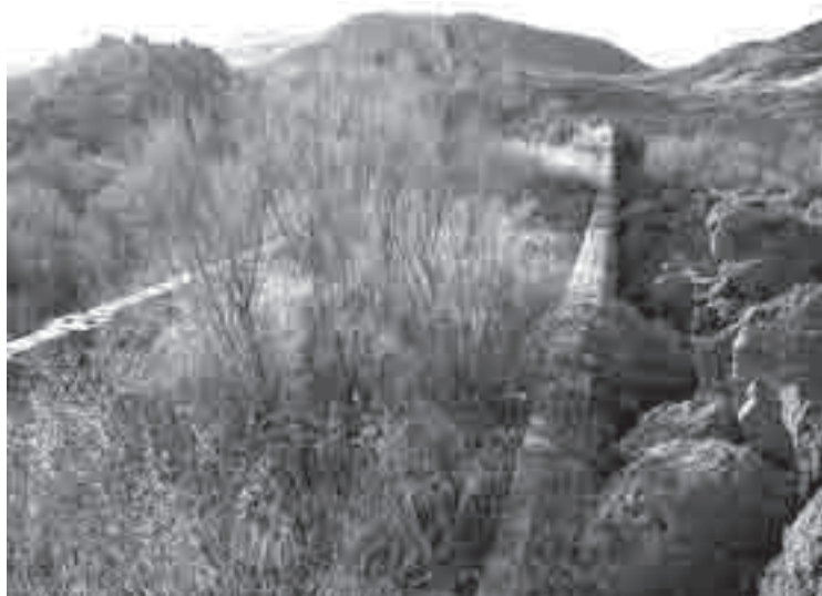
Estado actual de la trinchera abierta para el corrimiento de los tramos en el lado de Linares
