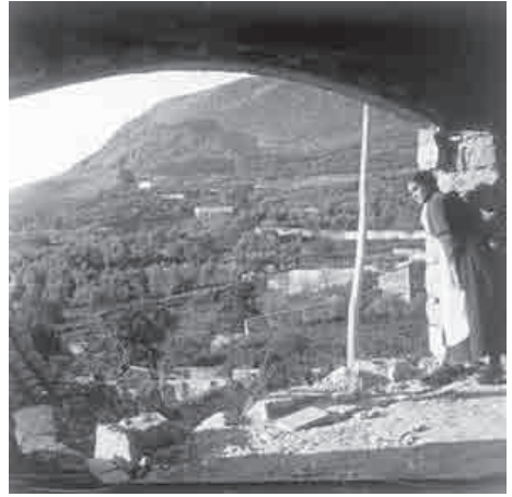
El Nacimiento desde la casa de Enrique Cerdá Serrano, en construcción, de la calle Santa Ana. h.1902 (Foto 7-Col. A. Cerdá y Rico)
