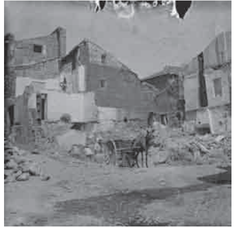
(Foto 16-Col. A. Cerdá y Rico) Calle de la Palma. Demolición para la obra de la nueva casa del Dr. Cerdá . 1897.
