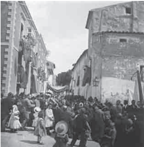
(Foto 17-Col. A. Cerdá y Rico) Calle de la Palma. Ya está terminada la casa del Dr. Cerdá. Ya se han sustituido otras viviendas y se empiezan a construir otras en el nuevo estilo 1900.
