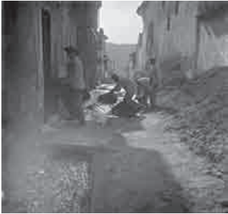
Sobrante de aguas del Nacimiento corriendo por la calle Santa Ana y aprovechadas en este caso para una obra. 1898. (Foto 11-Col. A. Cerdá y Rico)
